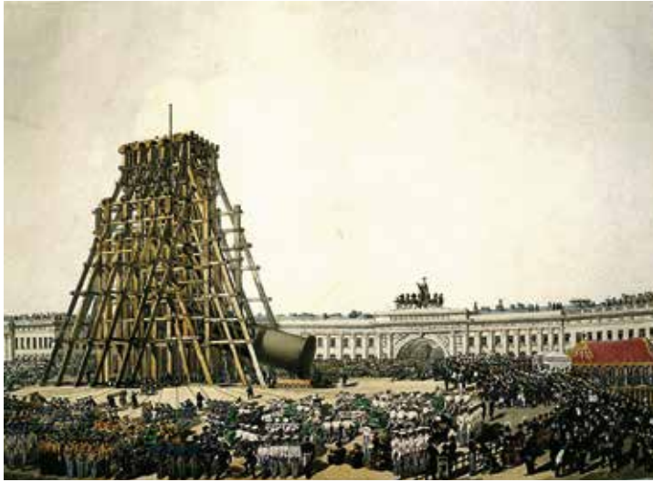
Elevació de la columna d'Alexandre I, a Plans et detalls del monument consacré a la memòria de l'Empereur Alexandre , d'Auguste de Montferrand, 1836 (Universitat Estatal de Vies de Comunicació, Sant Petersburg).
