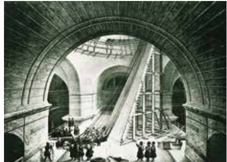
Elevació d'una columna pel tambor de la cúpula, a Église cathédrale de Saint-Isaac... , d'Auguste de Montferrand, 1845 (Universitat Estatal de Vies de Comunicació, Sant Petersburg).
