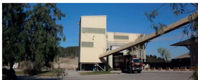
Instal·lació de Ciments Molins Industrial, i per a la utilització de combustibles alternatius en el seu procés de fabricació. Entrada de CSR procedent de l'empresa PRONATUR.
