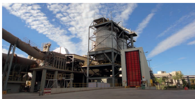
Instal·lació de Ciments Molins Industrial, i per a la utilització de combustibles alternatius en el seu procés de fabricació. Entrada de llots procedents de depuradores.
