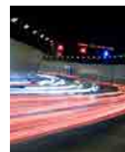
25 anys del Túnel de Vallvidrera
